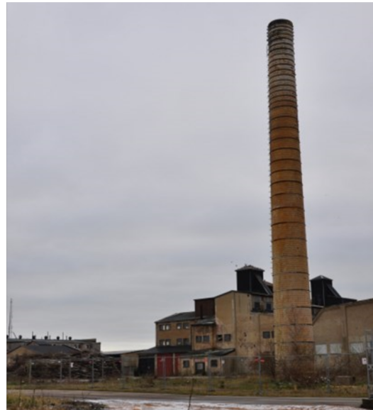
Endast en av de nio skorstenarna står kvar som ett minnesmonument över Skromberga.
