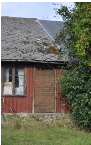
Ett bevarat gruvhus i Skromberga. Dörren är intakt från svunna gruvtider.
